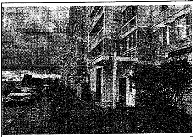
Фото № 2. Общий вид подъезда
