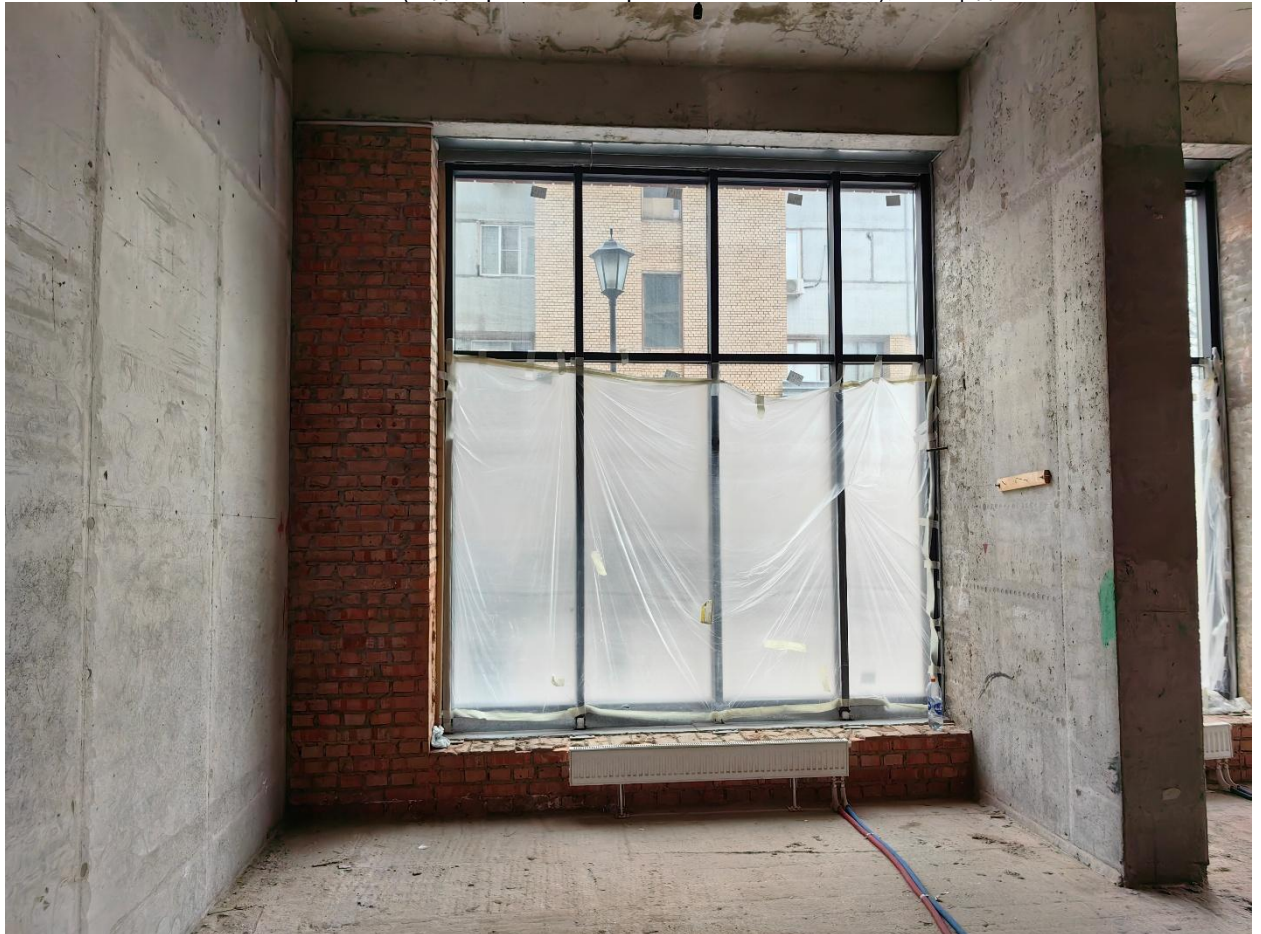
г. Москва, вн.тер.г. муниципальный округ Сокольники, улица Рубцовско-Дворцовая, д. 4: нежилое помещение 2Н (кадастровый номер 77:03:0003007:5256), площадью 116,6 кв.м
