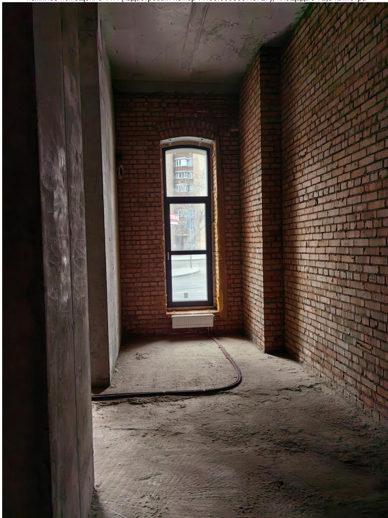
г. Москва, вн.тер.г. муниципальный округ Сокольники, улица Матросская Тишина, д. 12: нежилое помещение 11Н (кадастровый номер 77:03:0003007:5727), площадью 72,8 кв.метра
