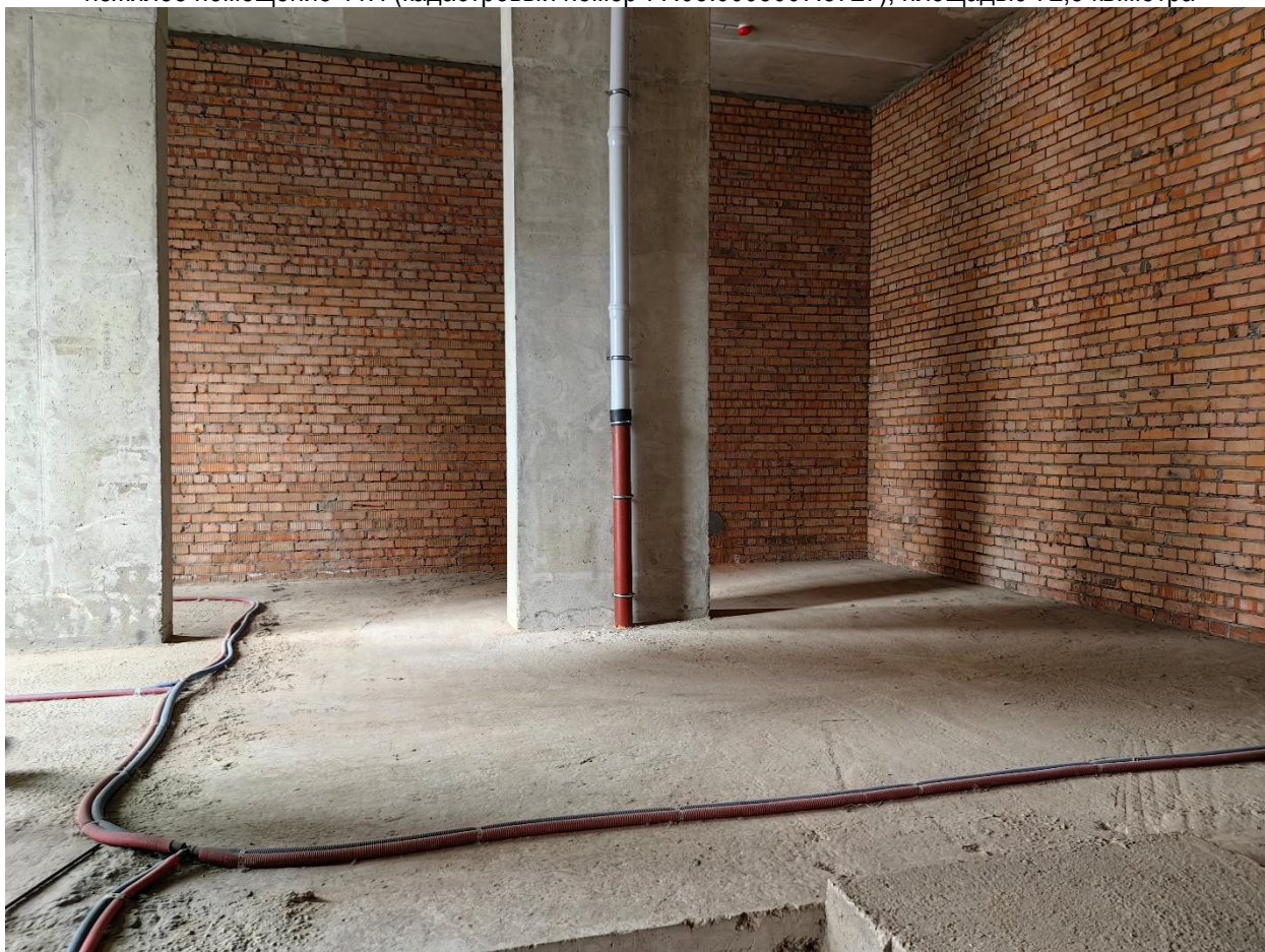
г. Москва, вн.тер.г. муниципальный округ Сокольники, улица Матросская Тишина, д. 12: нежилое помещение 11Н (кадастровый номер 77:03:0003007:5727), площадью 72,8 кв.метра
