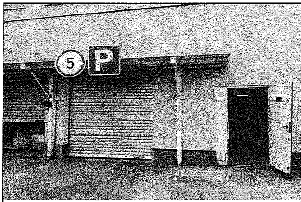
Фото № 2. Вид вход на паркинг
