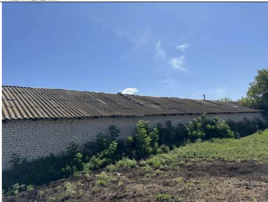
Фото 2. Общий вид здания
