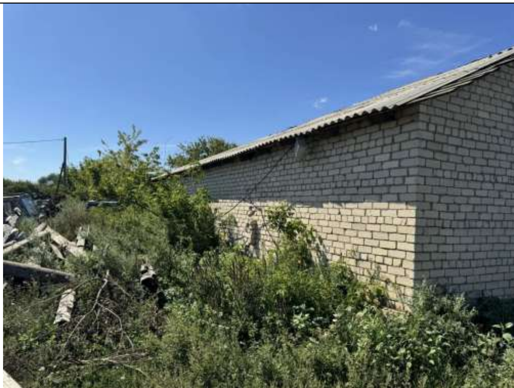
Фото 4. Общий вид здания
