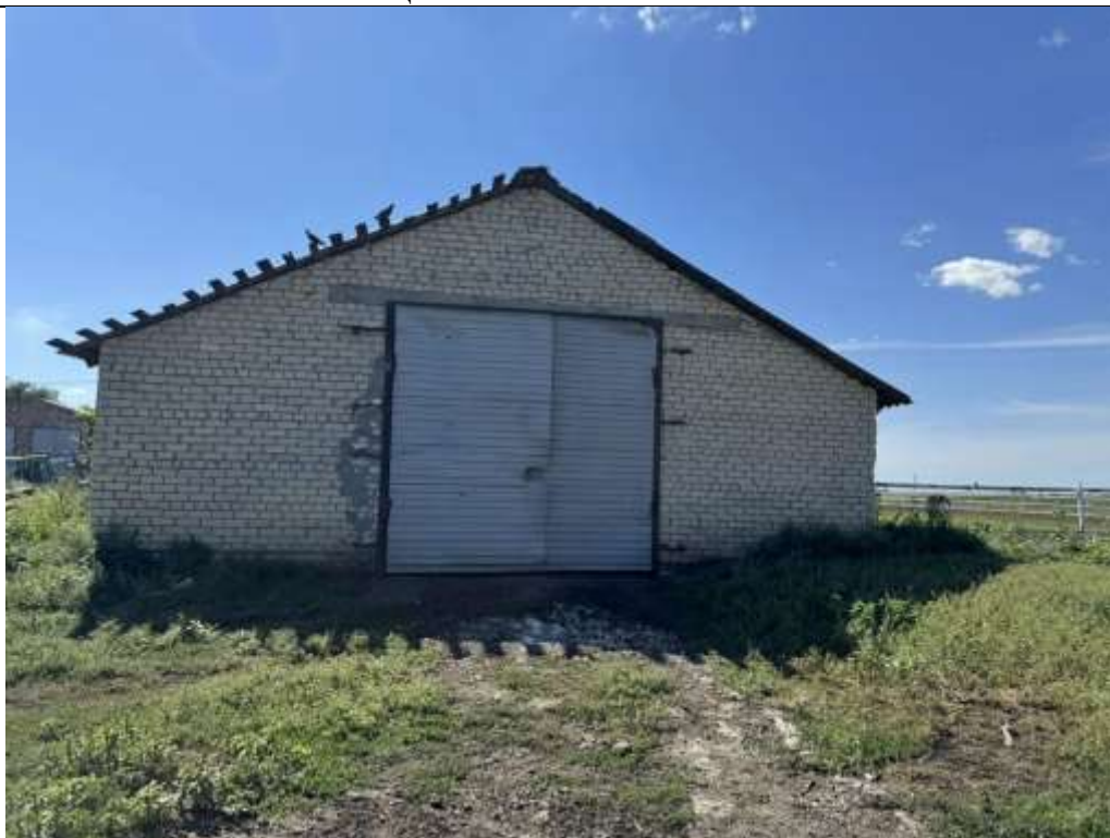
Фото. 1. Общий вид здания
