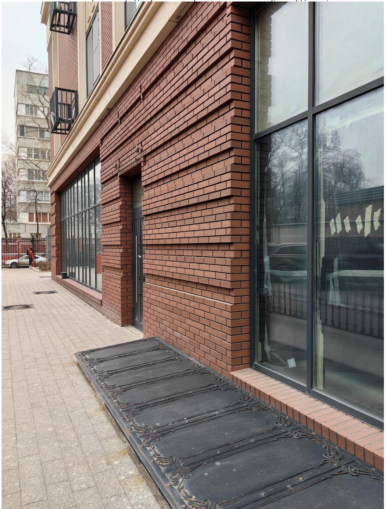
г. Москва, вн.тер.г. муниципальный округ Сокольники, улица Рубцовско-Дворцовая, д. 4: нежилое помещение 1Н (кадастровый номер 77:03:0003007:5255), площадью 68,8 кв.м
