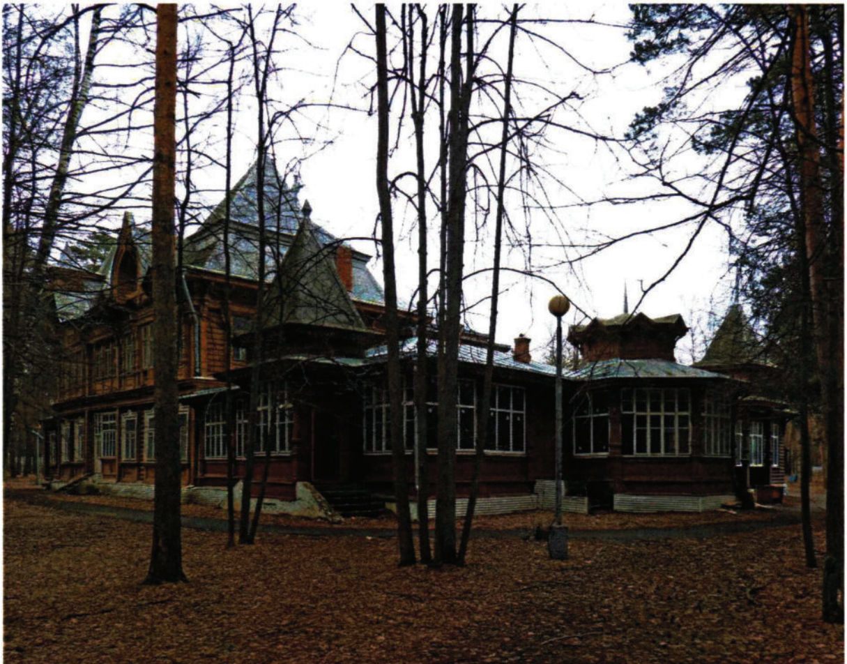
1. Общий вид здания с северо-запада.
