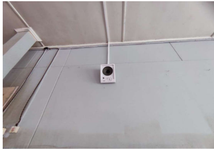
Поз.57. Настенный громкоговоритель LPA 10W-1 (для охранно-пожарной сигнализации)
